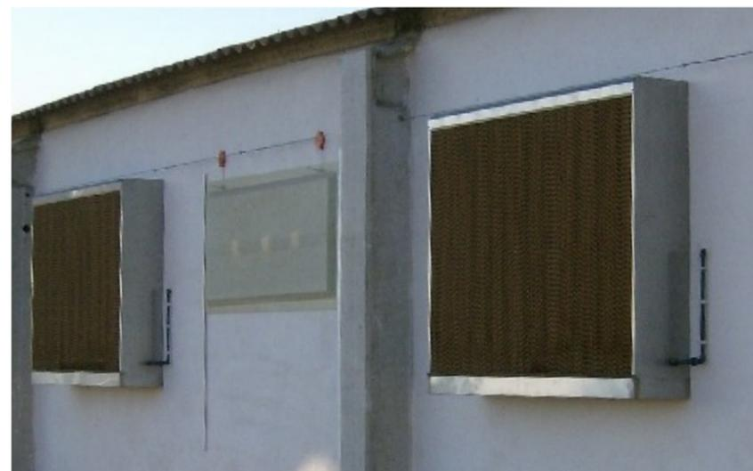
**E** Además permite refrigerar instalaciones con diseños complejos o simplemente reforzar zonas que quedan aisladas. La instalación es muy sencilla. No es necesario hacer grandes reformas para acoplar un MODULO DE REFRIGERACIÓN, solo se precisa sujetarlos a la pared y conectarlos al agua y a la electricidad.
