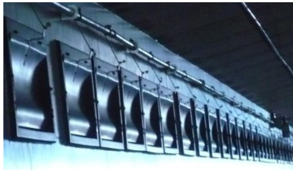
**E** Su diseño permite graduar la entrada, velocidad y dirección del aire en la granja en función de las necesidades. Efectúa una correcta renovación del aire, minimizando las corrientes. La aerodinámica forma del álabe mejora el flujo del aire e impide que este se desplome al entrar
