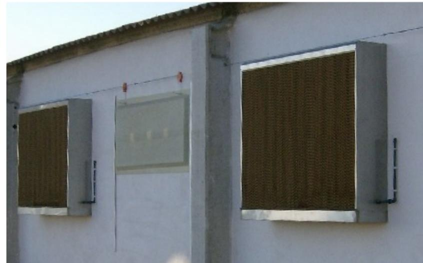
**E** Además permite refrigerar instalaciones con diseños complejos o simplemente reforzar zonas que quedan aisladas. La instalación es muy sencilla. No es necesario hacer grandes reformas para acoplar un MODULO DE REFRIGERACIÓN, solo se precisa sujetarlos a la pared y conectarlos al agua y a la electricidad.
