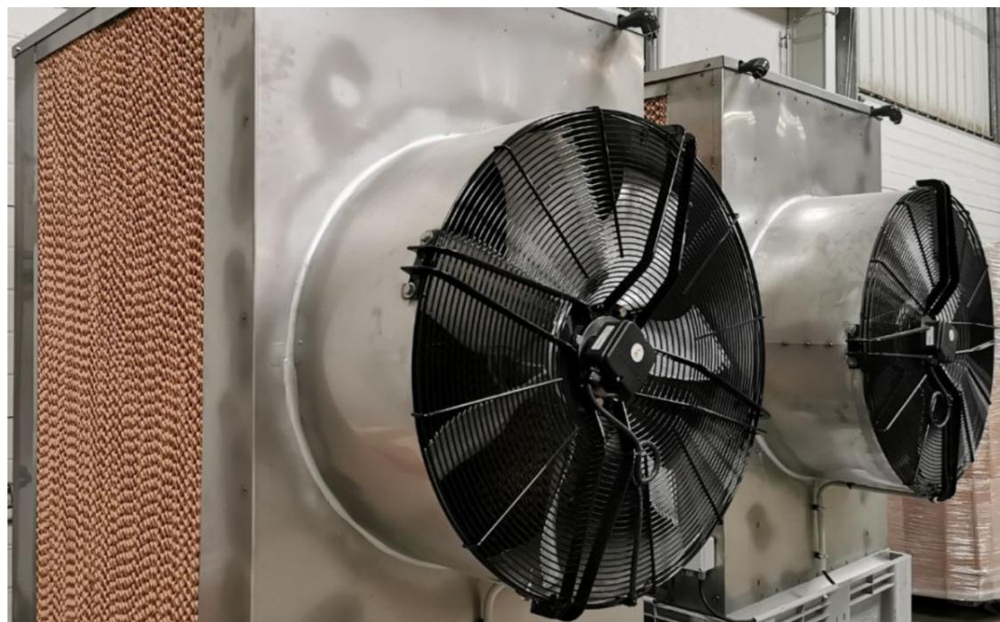
**E** El ECO-COOLING es un equipo con un caudal de 30.000 m3. Además permite refrigerar instalaciones con diseños complejos o simplemente reforzar zonas que quedan aisladas. La instalación es muy sencilla. No es necesario hacer grandes reformas para acoplar un ECO-COOLING
