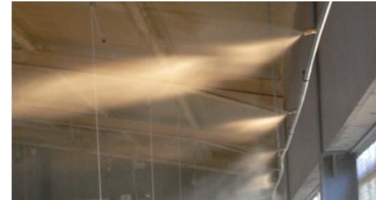
**E** En combinación con la ventilación estática o dinámica, el sistema de NEBULIZACIÓN es la forma más económica de eliminar el impacto negativo de las altas temperaturas sobre la producción. La nebulización efectiva ha de refrescar sin mojar. Por eso nuestras BOQUILLAS están diseñadas para conseguir gotas tan pequeñas que garantizan su suspensión y el perfecto intercambio de frío con el ambiente. Sin goteos ni concentraciones de humedad
