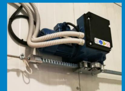
**MOTORES ESPECIALES CON CREMALLERA PARA UN AJUSTE OPTIMO DE LA REGULACIÓN**
